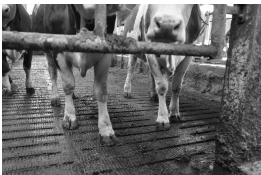
Abbildung 1: Betonspaltenboden mit Gummiauflage MEADOWFLOOR®, © tierschutzkonform.at
