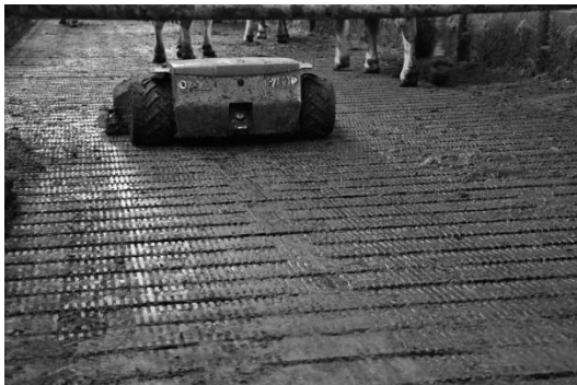
Abbildung 2: Betonspaltenboden mit Gummiauflage MEADOWFLOOR®, © tierschutzkonform.at
